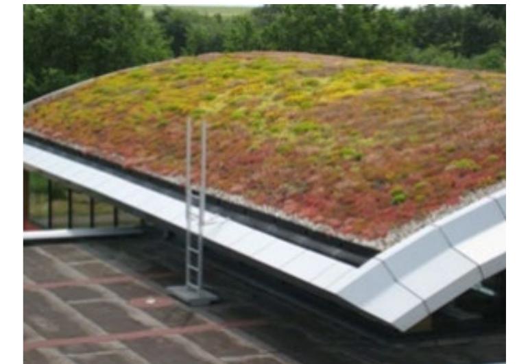
Afbeelding: passieve koeling d.m.v. sedumdak
