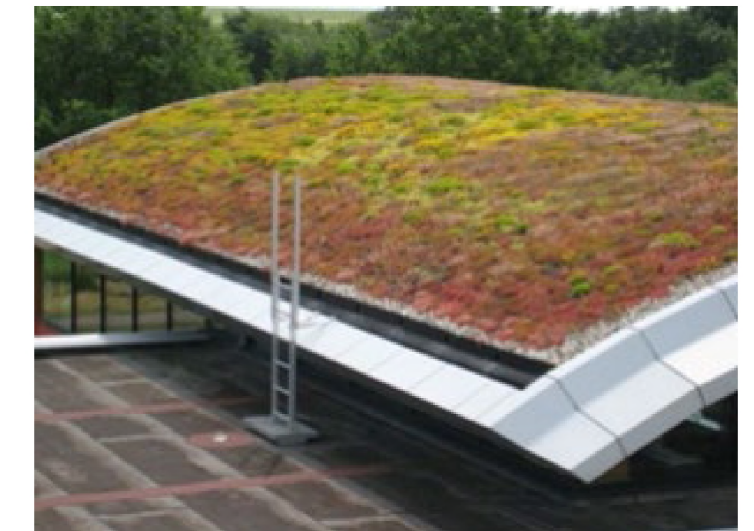
Afbeelding: passieve koeling d.m.v. sedumdak
