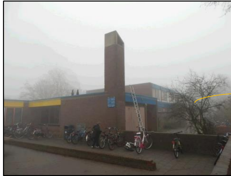
Renovatie Gymlokaal De Zuidert (VIV)
