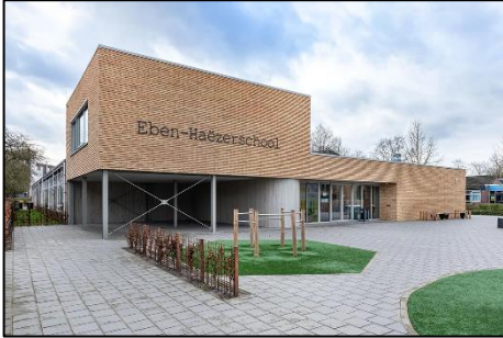
Renovatie Eben Haezerschool (VIV)
