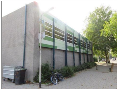
Renovatie Gymlokaal Revelsant (VIV)
