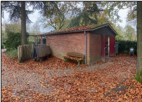
Onderzoek beheerders gebouw begraafplaats (VIV)
