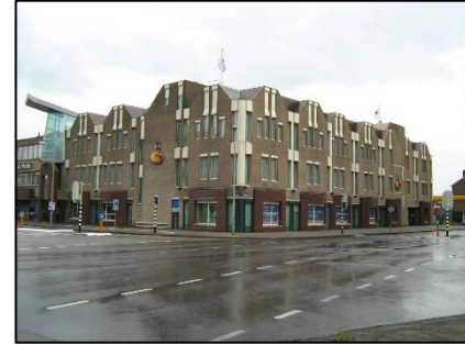
Verbouwing Deel 1 Emmeloord
