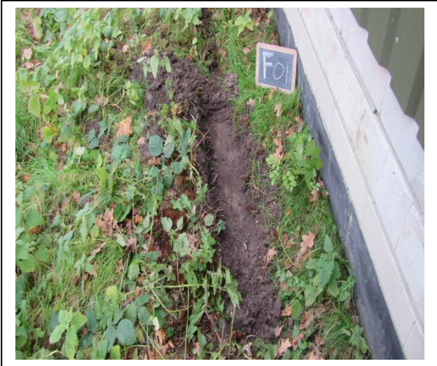
Foto: Inspectiegat F01
