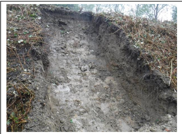
Foto: Inspectiesleuf H03
