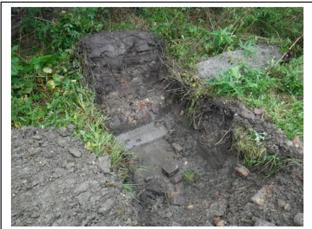
Foto: Inspectiegat G06
