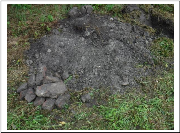
Foto: Inspectiegat G10
