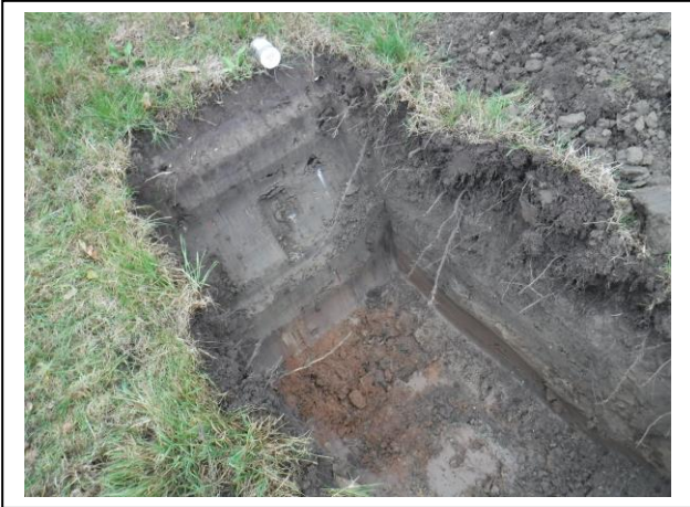
Foto: Inspectiegat G02
