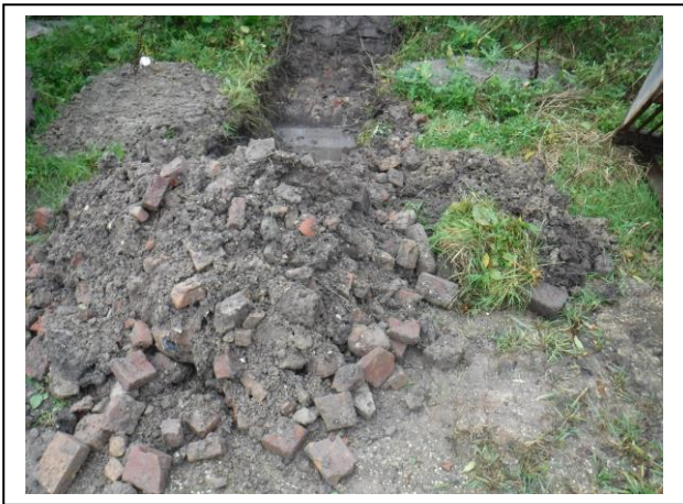
Foto: Inspectiegat G06
