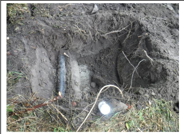
Foto: Inspectiegat G04
