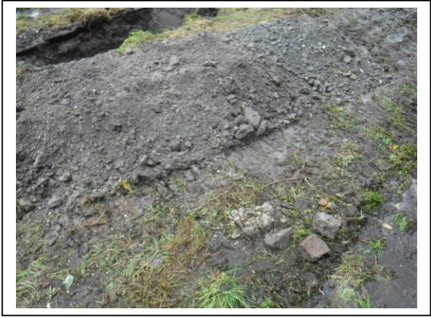
Foto: Inspectiegat G11
