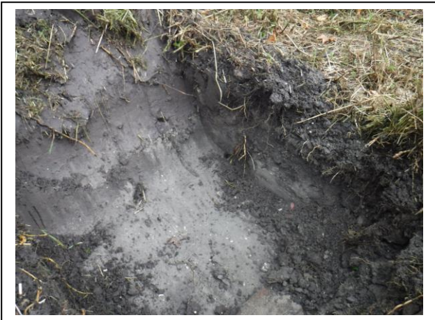
Foto: Inspectiegat G10
