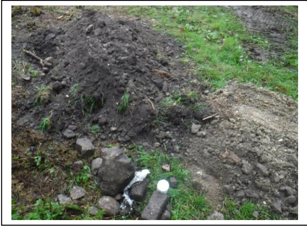
Foto: Inspectiegat G05
