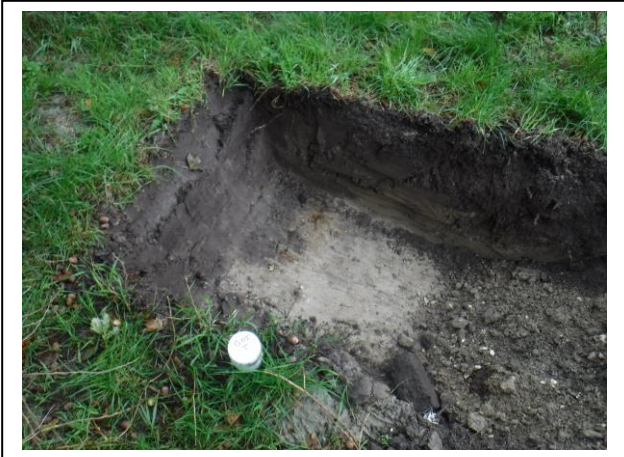
Foto: Inspectiegat G05
