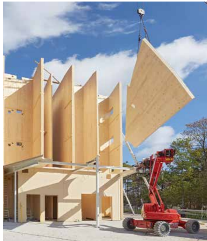
Aanbouw biobased gebouw - Triodos Bank / RAU Architecten, 2019
