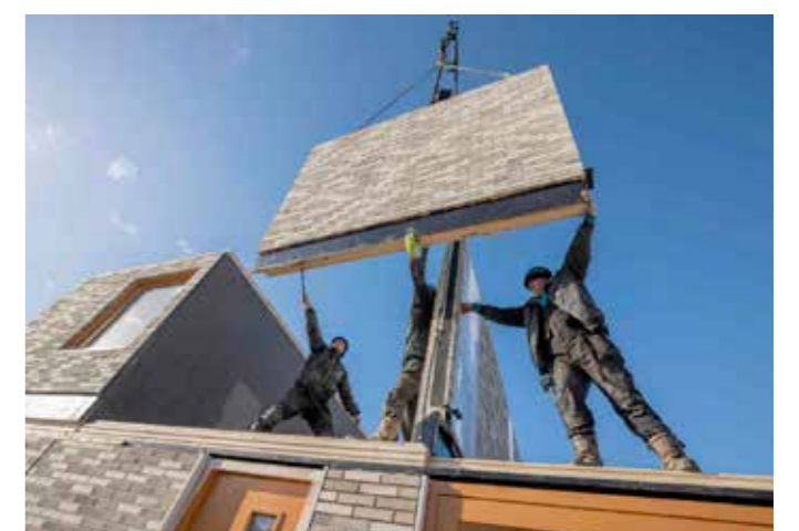
Circulair bouwsysteem voor 18 duurzame woningen in project Noorderwinkels Nagele / Kingspan TEK en OVT
