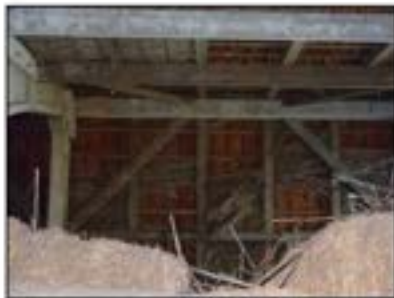
Figuur 14. Nok hooizolder linker schuur met afvallend riet.
