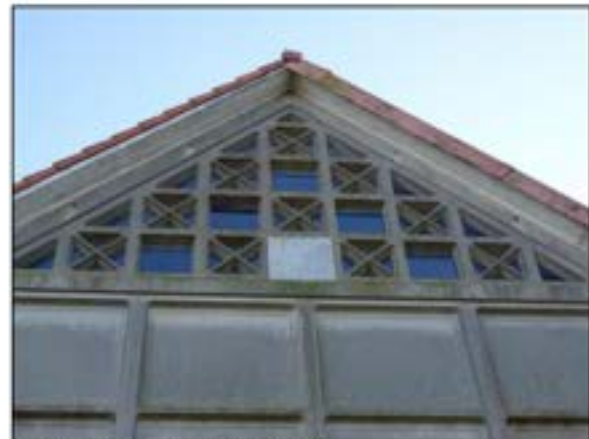
Figuur 10. Afwerking gevel schuur.
