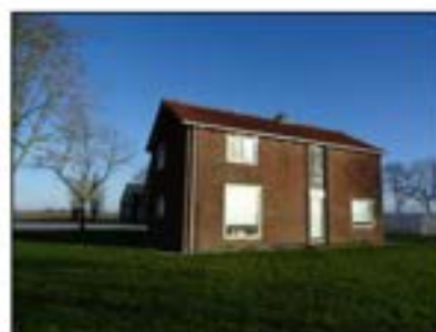
Figuur 5. Woonhuis gezien vanaf het zuidwesten.
