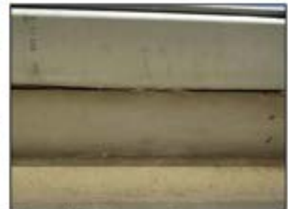
Figuur 13. Dakgoot met rietresten.
