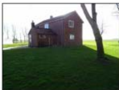
Figuur 4. Woonhuis gezien vanaf het noorden.
