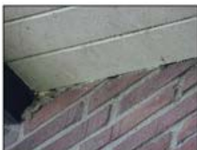
Figuur 17. Openingen onder overschot woning.
