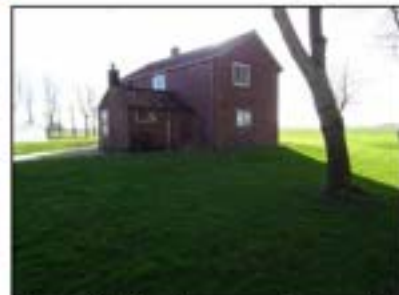
Figuur 8. Te slopen woning op de onderzoekslocatie.
