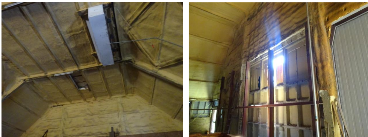
Figuur 1.6 Binnenzijde van de geïsoleerde schuur.
