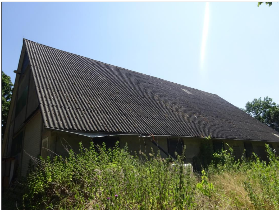
Figuur 1.3 Westzijde van de schuur.
