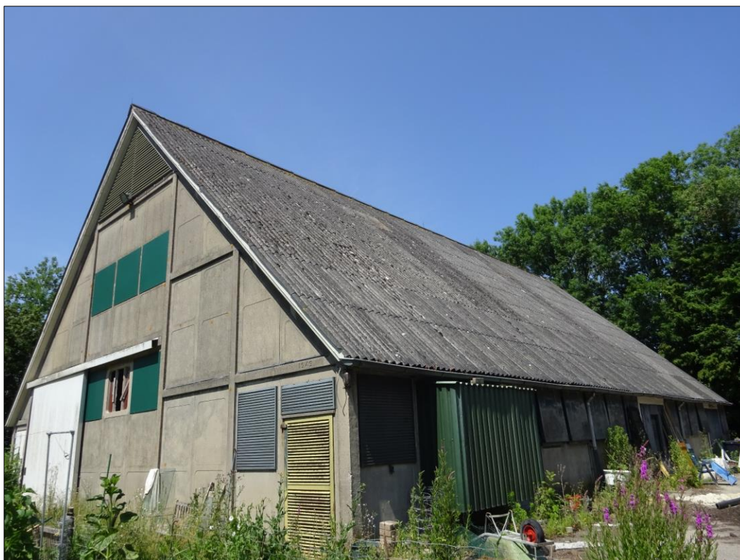
Figuur 1.5 Zuidoostzijde van de schuur.
