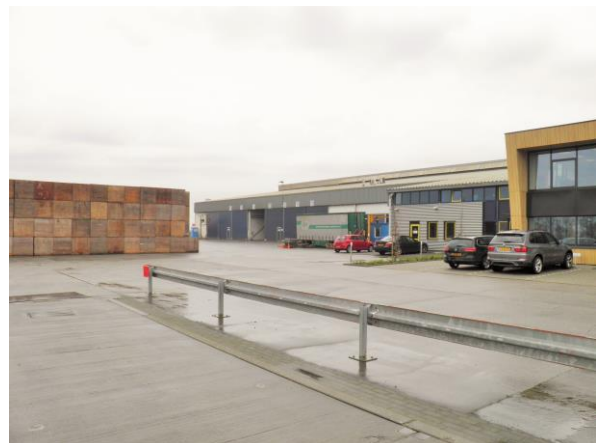
Figuur 3. Overzicht van het zuidelijke deel van het terrein.
