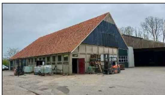
Afbeelding 1.3. Meest noordelijk gelegen schuur met gekoppelde schuur rechts.
