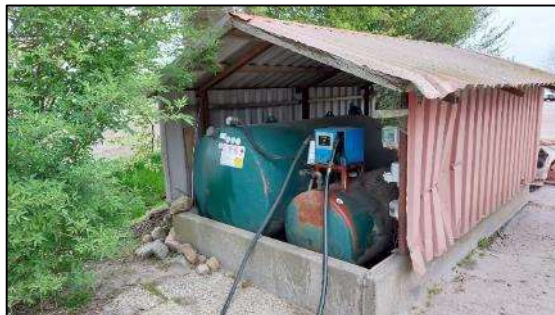
Afbeelding 1.5. Dieseltank.
