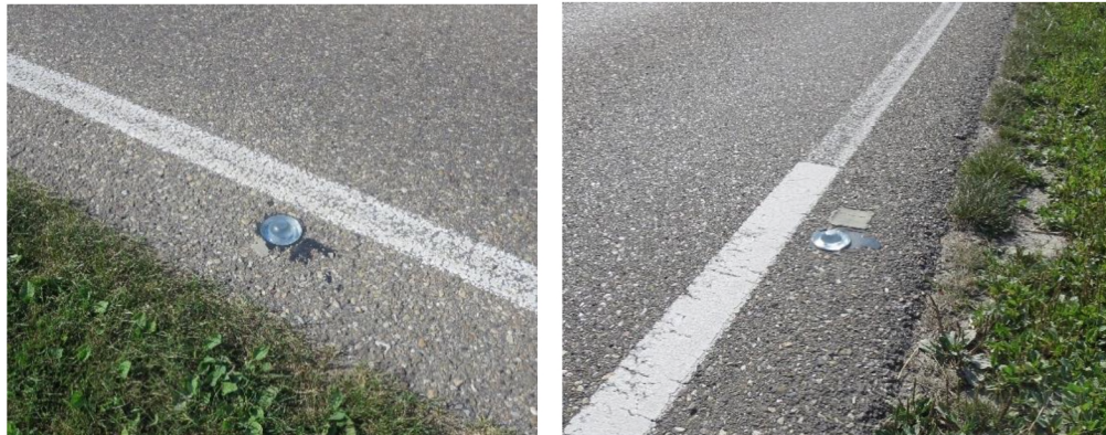
Afbeelding 11: Glasbollen dienen als wegdekreflectoren.
