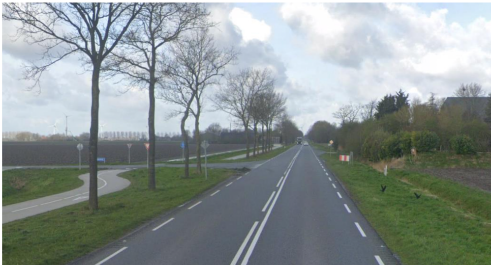
Afbeelding 4: Schokkerringweg ter hoogte van het kruispunt met de Sluitgatweg: één rijbaan met twee rijstroken met een doorgetrokken asmarkering en een onderbroken asmarkering. (Bron: Google Maps)
