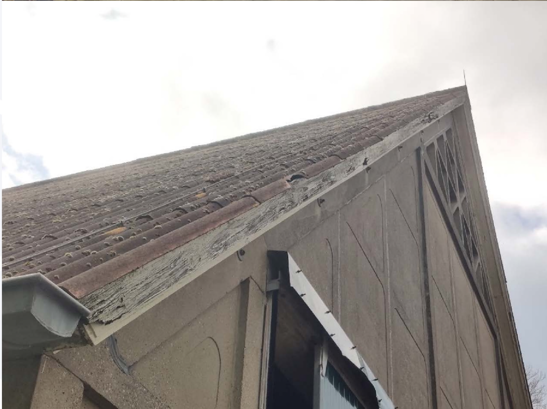
Figuur 4.9 Aanwezige golfplaten dak ter plaatse van de twee grote asbest schuren (boven). Aanwezig gaten aan de zuidwest kant van de domeinschuur nabij de aanhechting van het dak.
