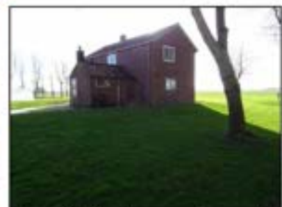
Figuur 8. Te slopen woning op de onderzoekslocatie.
