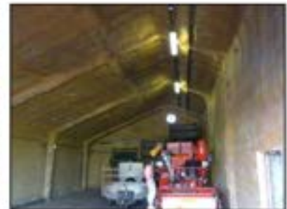
Figuur 16. Opslag/stalling kleine schuren, afgewerkt met porschuim.
