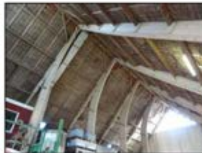
Figuur 15. Nok rechter schuur/ werkplaats.
