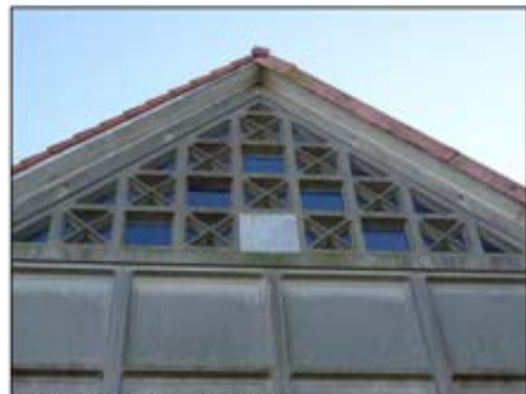
Figuur 10. Afwerking gevel schuur.
